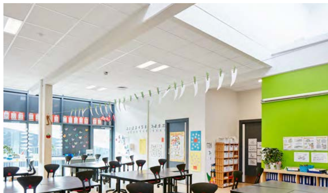
Doświetlenie sali oknem powyżej połaci dachu, Nordagerskolen Elementary School, Denmark, fot. Teddy Strandqvist, Studio-e-se
