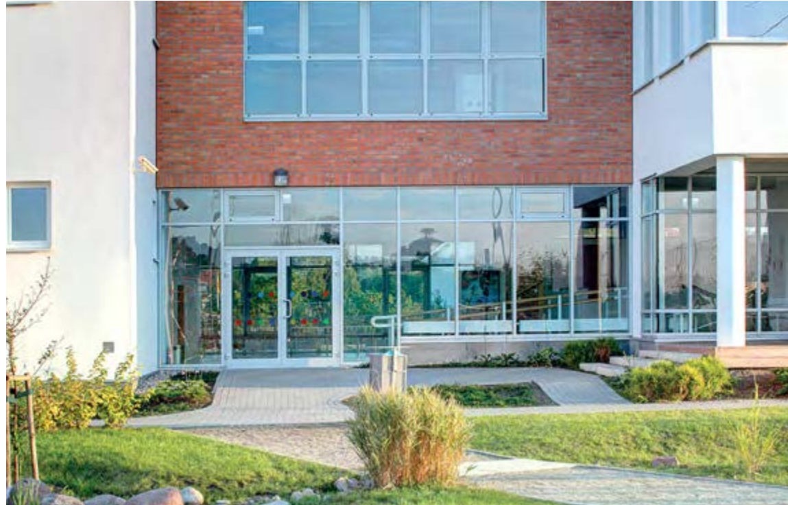
Szkola podstawowa w Książenicach, Książenice, Gmina Grodzisk Mazowiecki, PALK Architektki (obecnie Piotr Hardecki Architekt oraz LWS Architektki), fot. Bartek Makowski
