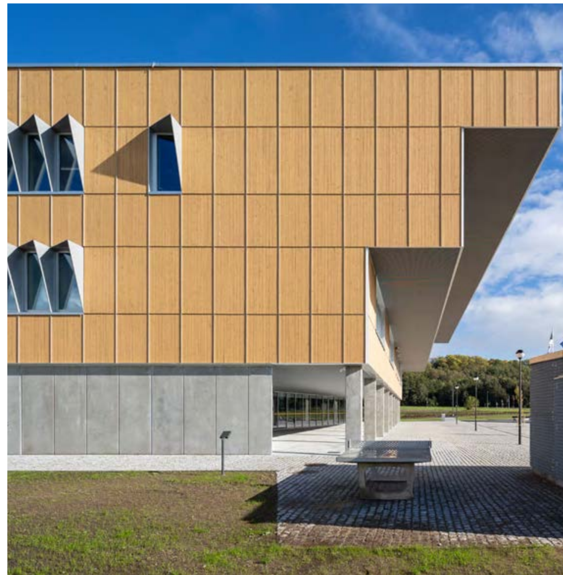
Konstrukcja oraz wykończenie budynku z drewna, Vilmsi State Secondary School, Rapperswil-Jona, Switzerland, KAMP Architects, fot. Mikael Olsson, Karin Gauch, Fabien Schwartz
