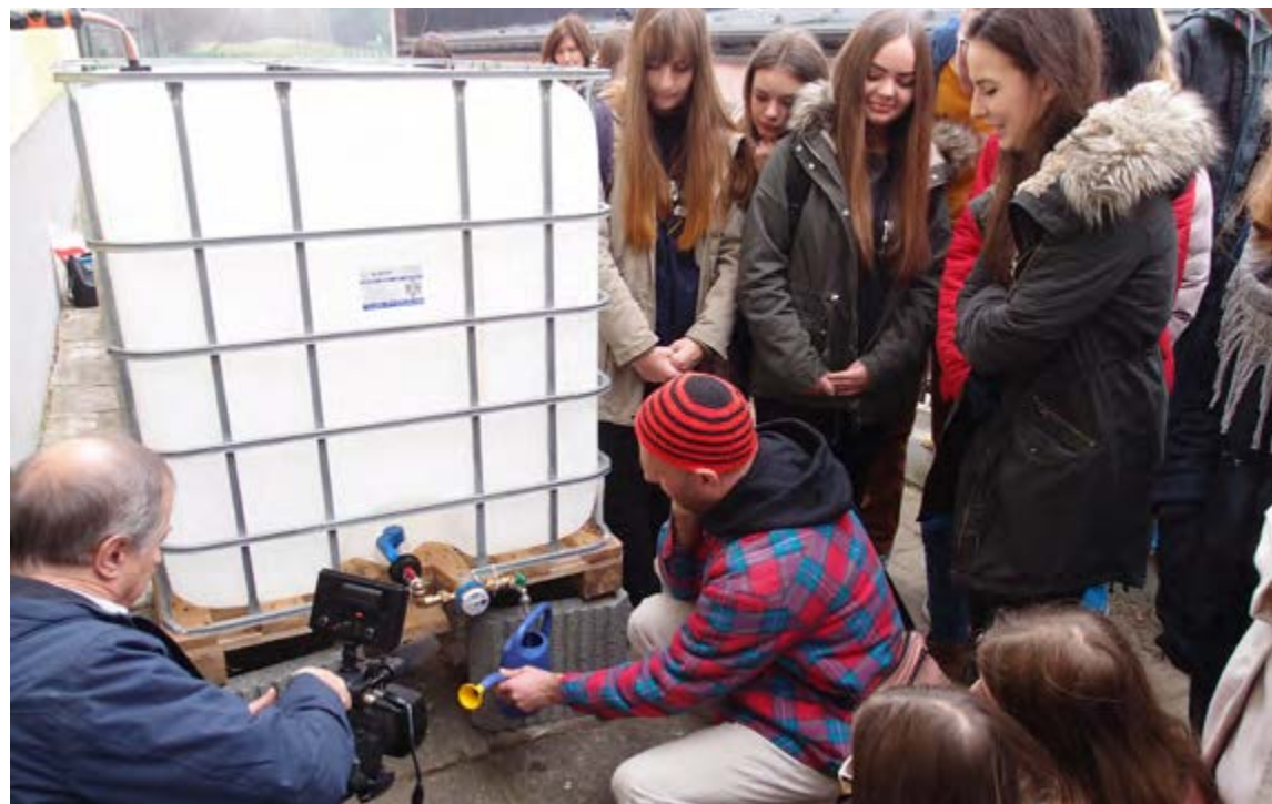
Instalacja 1000 litrowego zbiornika na wodę opadową, wykorzystywaną do podlewania roślin doniczkowych w szkole, w ramach programu „Zaadaptuj rzekę” prowadzonego przez Klub Gaja. Zespół Szkół nr 3, Rybnik, fot. Archiwum Klubu Gaja
